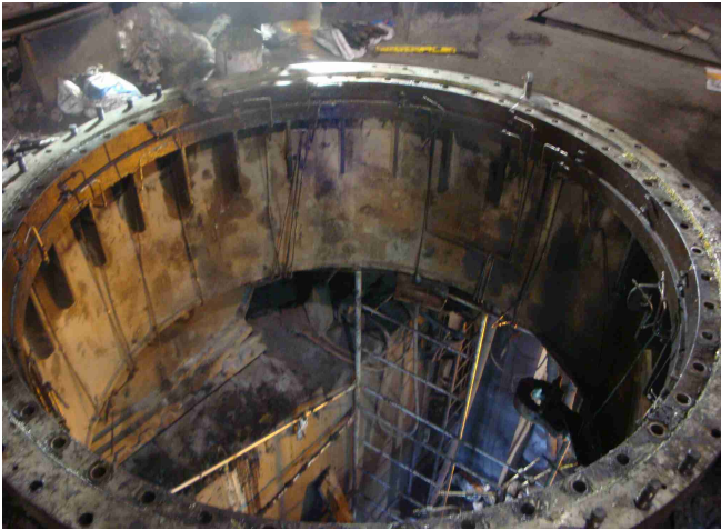
Fuente: DSC02473.JPG Asiento de la pista a maquinarse
